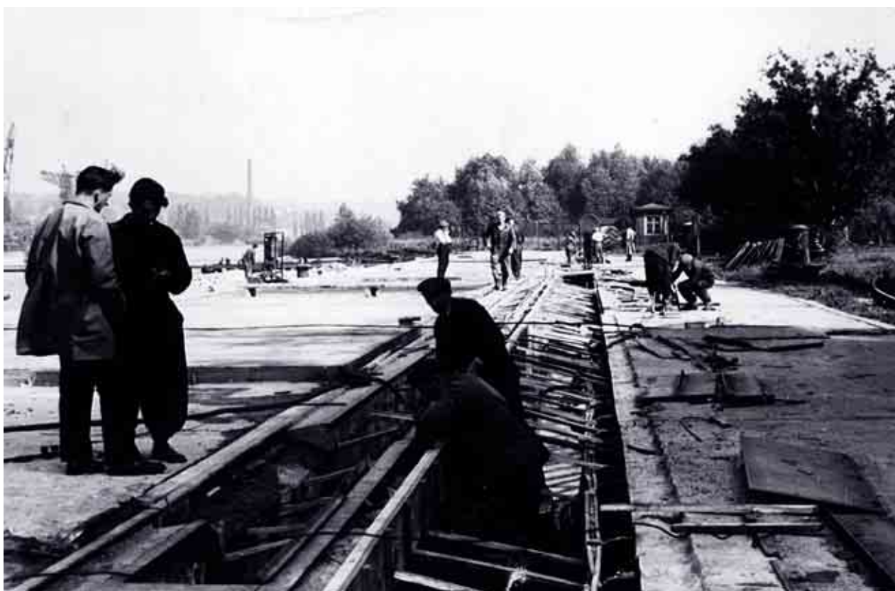
Remont Nabrzeża Gdańskiego (1958 rok)
