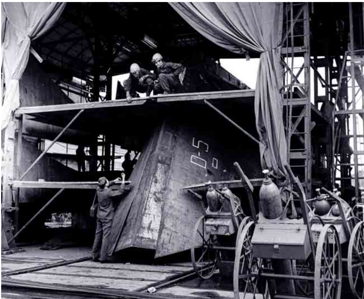
Montaż kadłuba kutra
