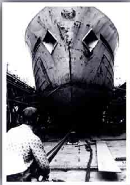
SUNNBERG – w czasie prac przy przedłużeniu (1989 rok)
