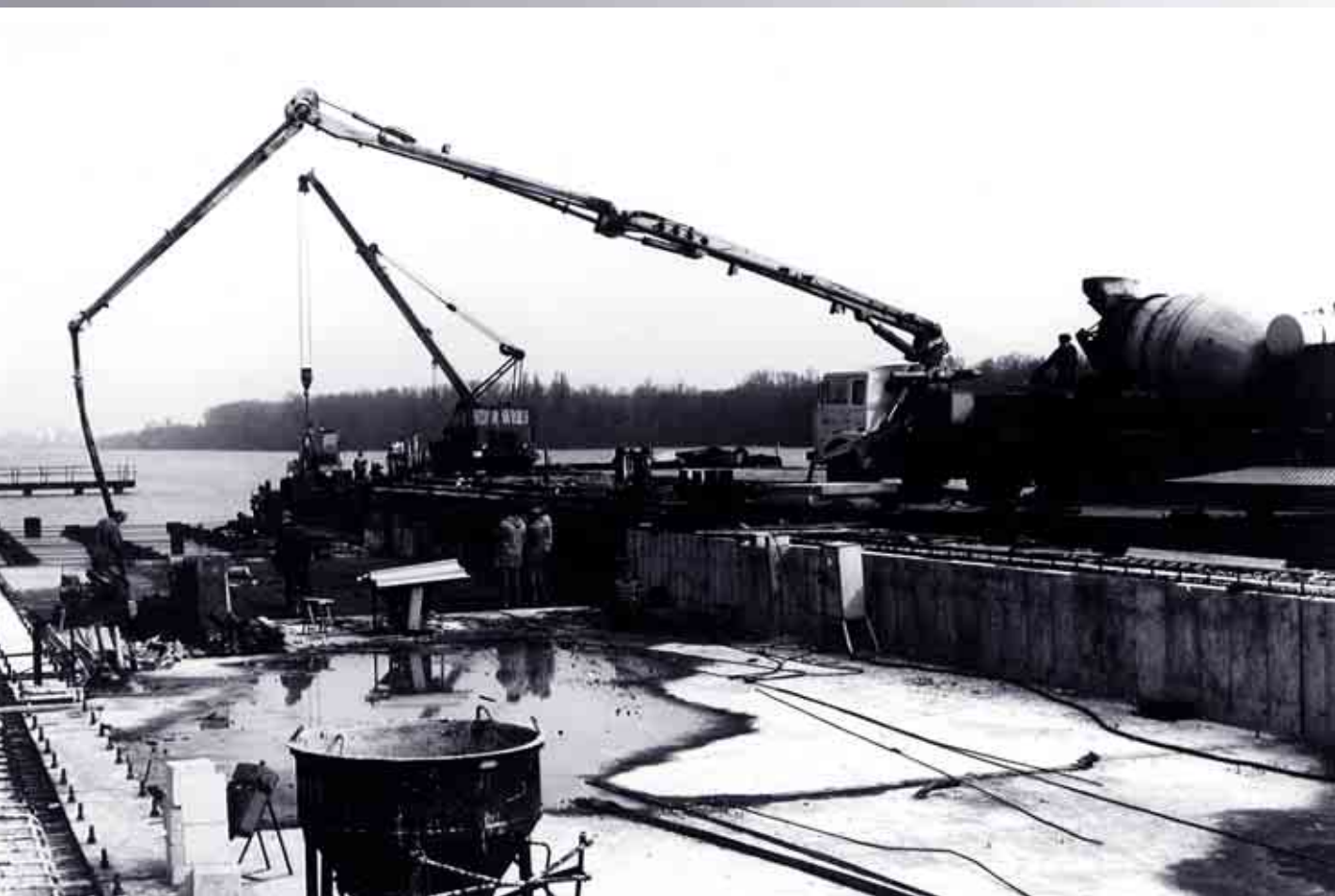
Prace przy umacnianiu nabrzeży na Wyspie Dolnej Okrętowej (1989 rok)
