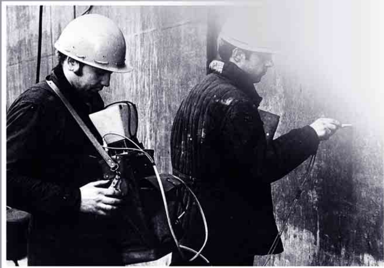
Wprowadzenie nowoczesnego defektoskopu ultradźwiękowego do mierzenia grubości poszycia statków (1967 rok)
