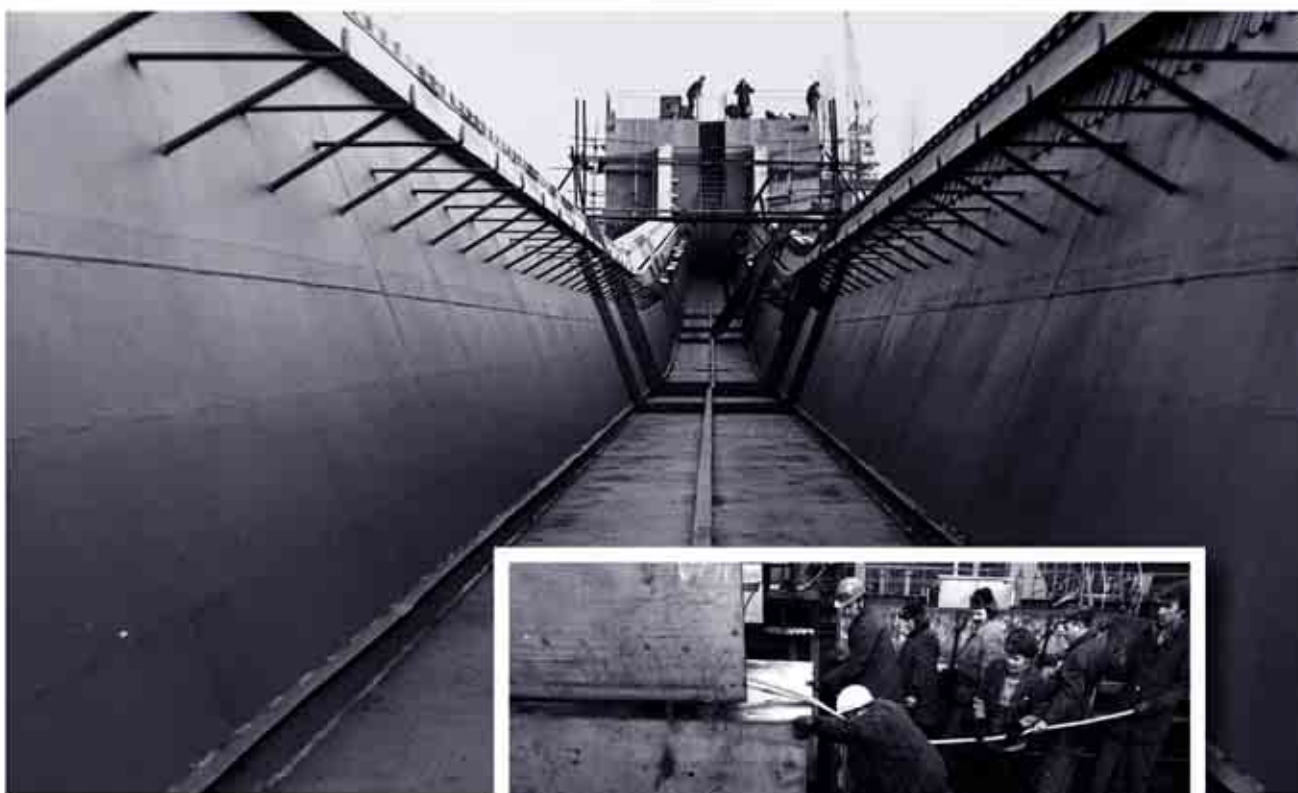
Budowa tunelu do spawania pod wodą (1978 rok)
