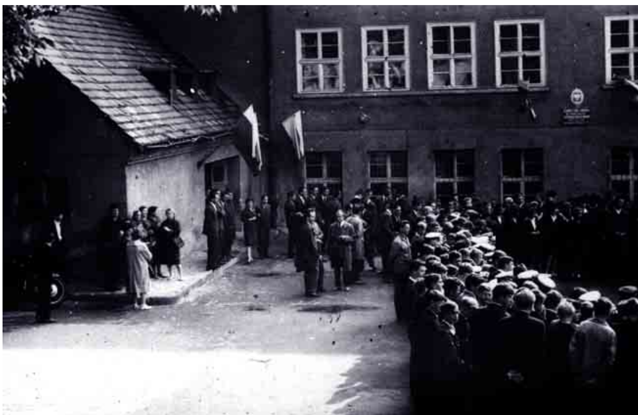
Oddanie do użytku szkoły przyzakładowej kształcącej przyszłe kadry stoczni (1963 rok)
