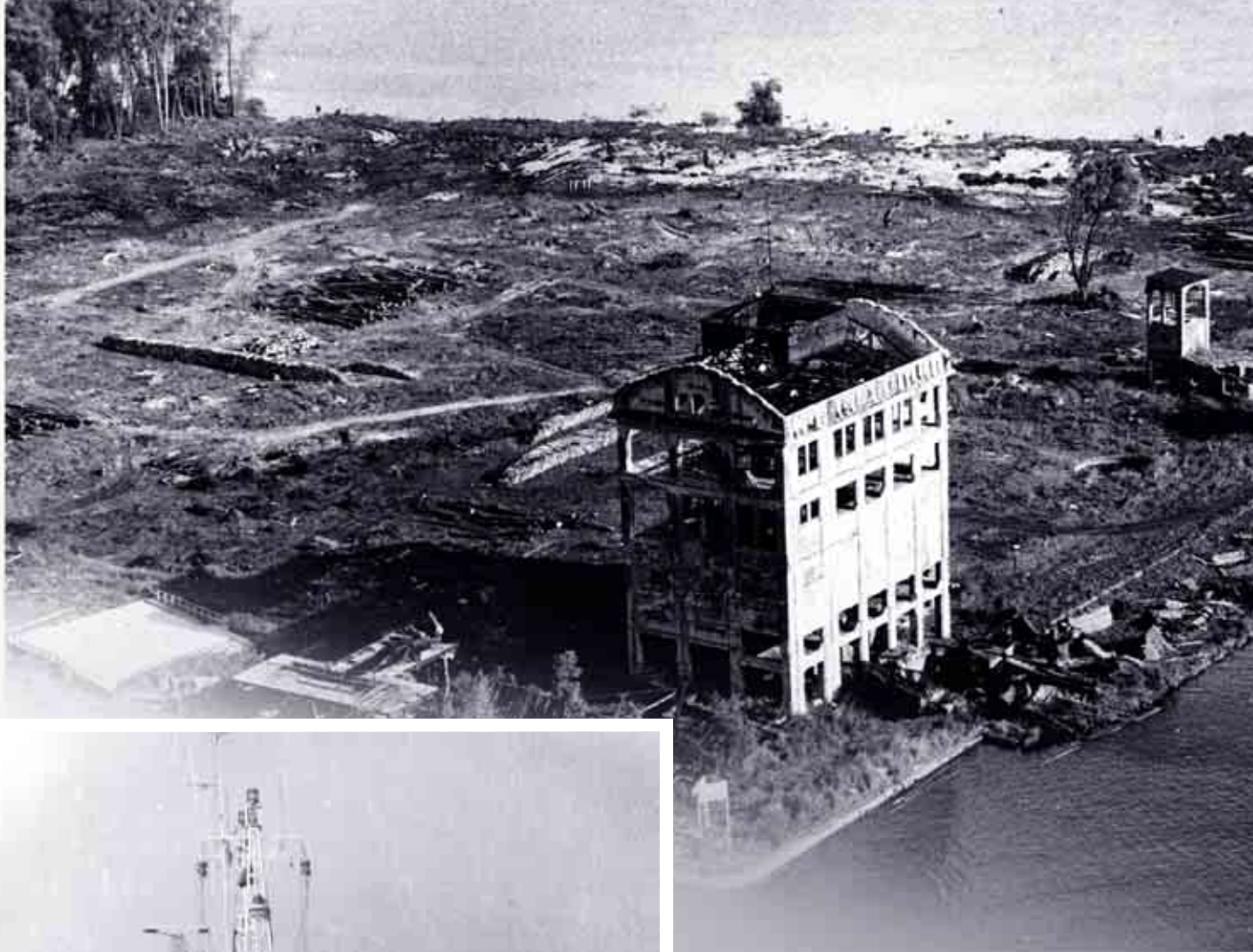
Przygotowywanie terenu Wyspy Dolnej Okrętowej pod planowane inwestycje – brykielniarnia przed zburzeniem (1986 rok)
